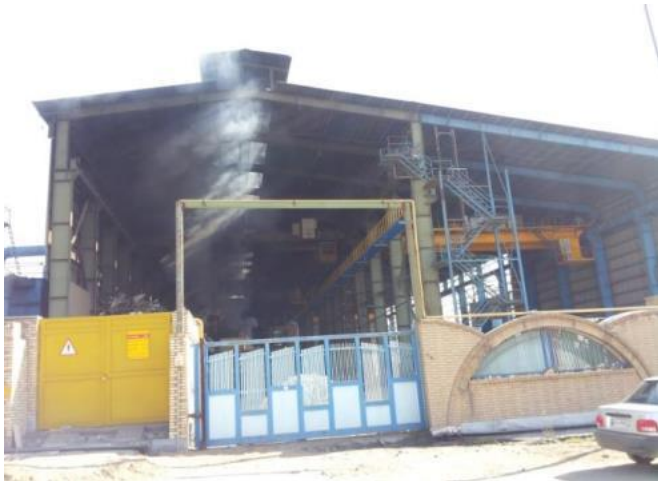
کارخانه ذوب آهن آسیا
