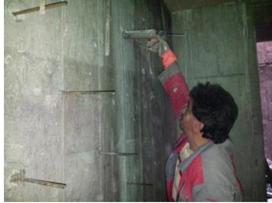
کاشت آرماتور جهت تقویت دیوار حائل
