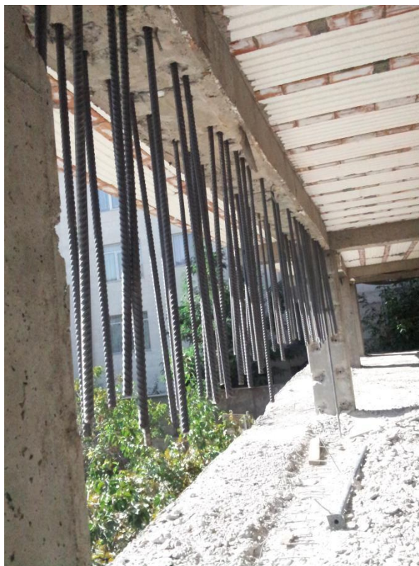
سوراخکاری راه به در و کاشت میلگرد
