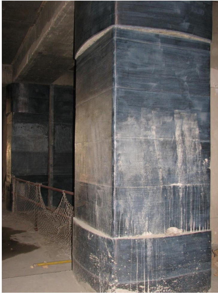
ستون های Reprofiled و تقویت دورپیچ با CFRP
