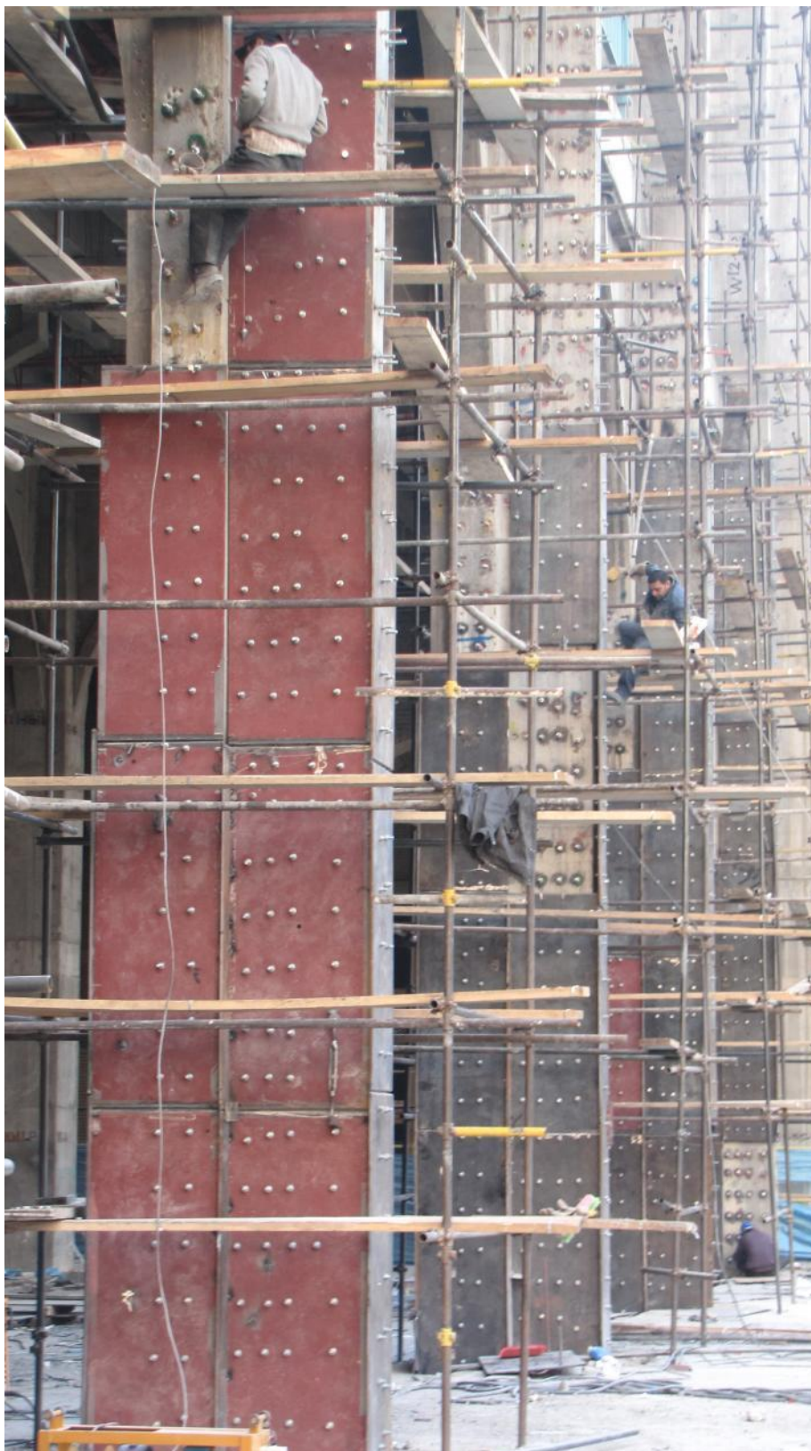
اجرای ژاکت فولادی
