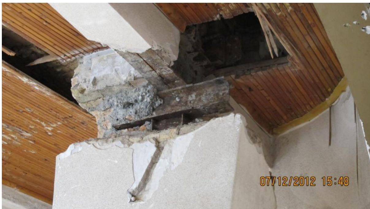
اتصال تیر به ستون در محل سونداژ
