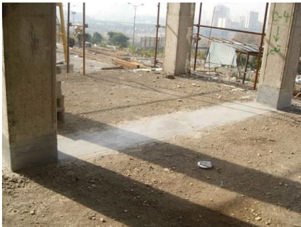
تقویت خمشی در روی تیر
