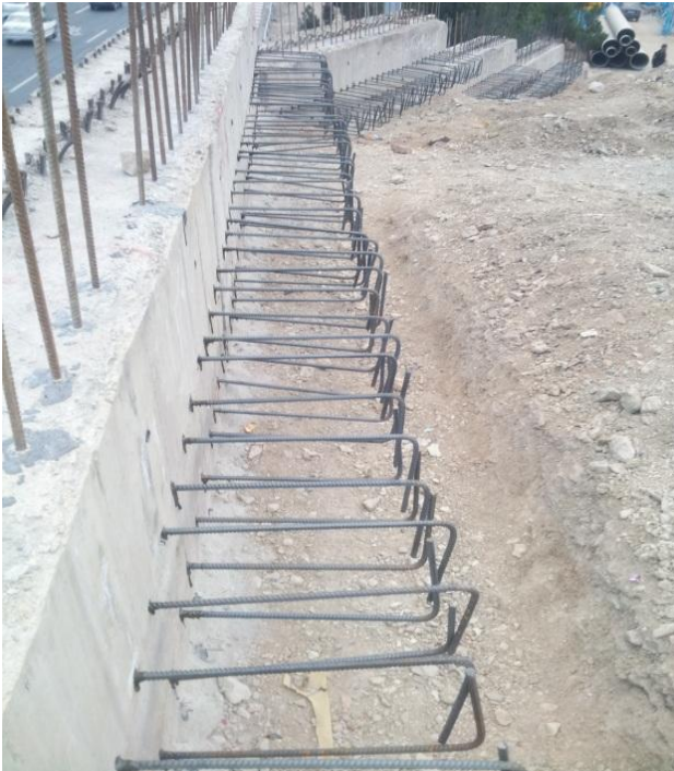
کاشت میلگرد ریشه فونداسیون و دیوار حائل در بتن
