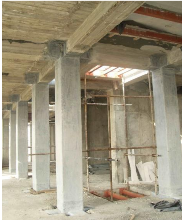
تقویت خمشی ستون
