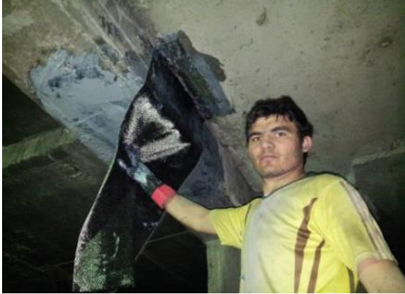
تقویت تیرهای رمپ توسط CFRP
