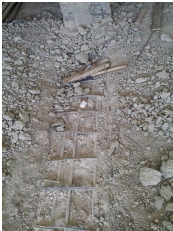
تخریب کاور تیر جهت آماده سازی سوراخکاری راه به در
