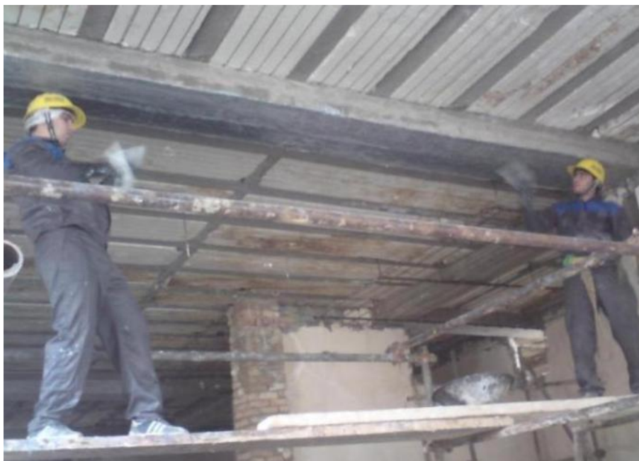
اجرای FRP SikaWrap-200C جهت قوت تیرها
