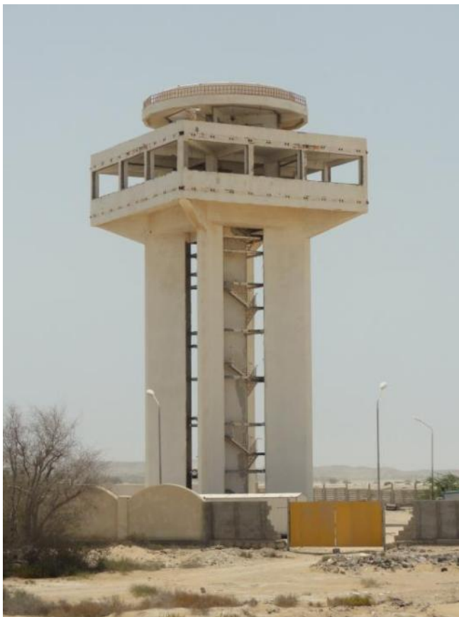
پس از وقوع زلزله
