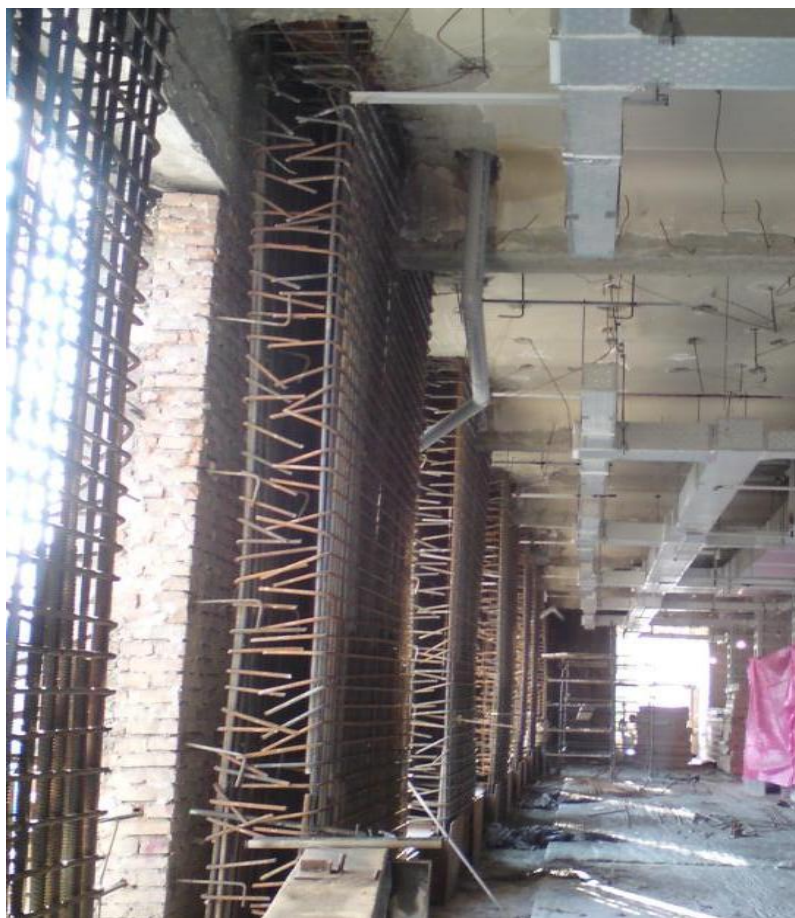
اجرای دیوار برشی جدید درون دال
