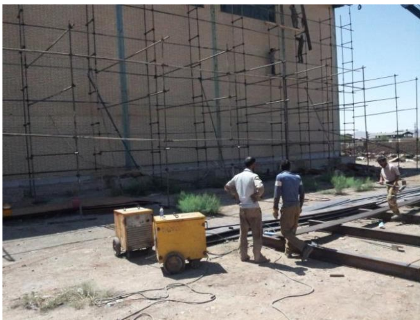
تقويت ستون هاى سوله کارخانه ذوب آهن آرمان آسيا
