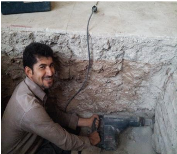
سوراخکاری و کاشت آرماتور در فونداسیون جهت تقویت فونداسیون سوله
