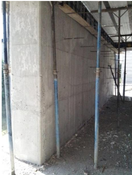
اجرای دیوار برشی
