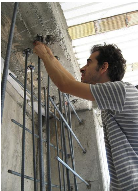
کاشت میلگرد ریشه دیوار برشی روی ستون و زیر تیر
