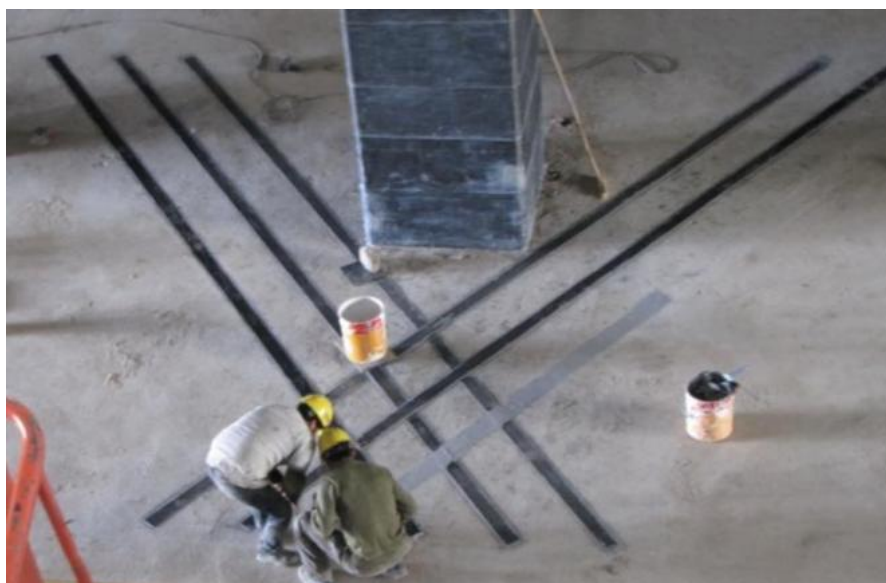
اجرای لمینیت جهت کنترل لنگرهای منفی و خیز دال
