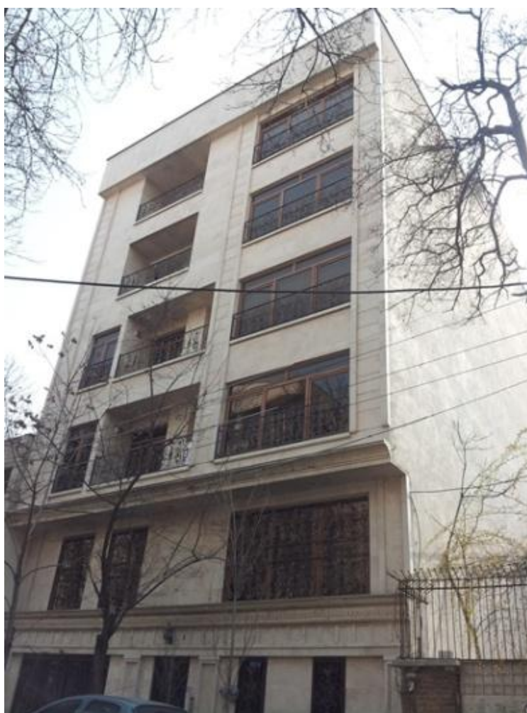
ساختمان مسکونی لنگرود
