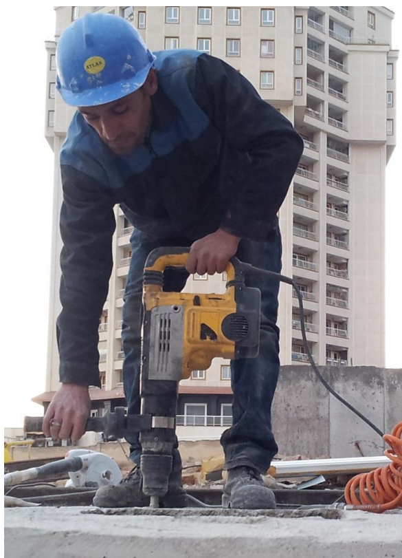
سوراخکاری در بتن
