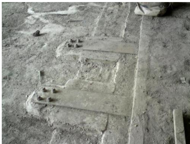
دوخت بلوک های مجزا به هم توسط پلیت های فلزی
