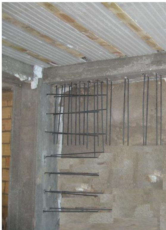
کاشت میلگرد ریشه دیوار برشی روی ستون و زیر تیر
