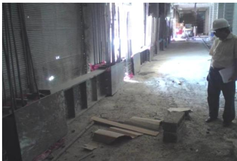
اجرای تیرهای همبند فلزی
