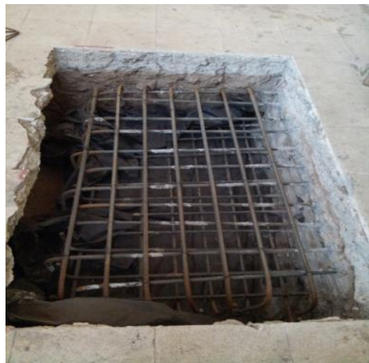
سوراخکاری و کاشت آرماتور در فونداسیون جهت تقویت فونداسیون سوله
