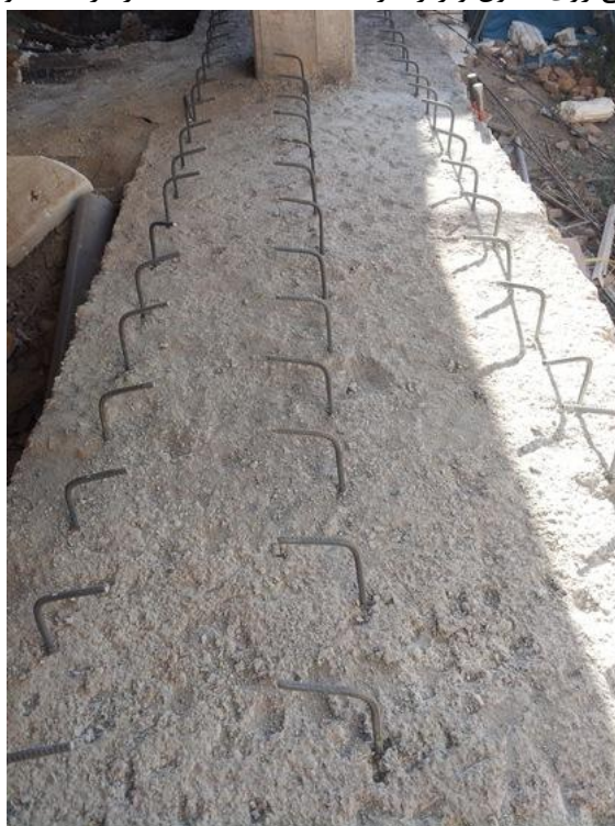
کاشت میلگرد برش گیر روی فونداسیون جهت افزایش ارتفاع فونداسیون
