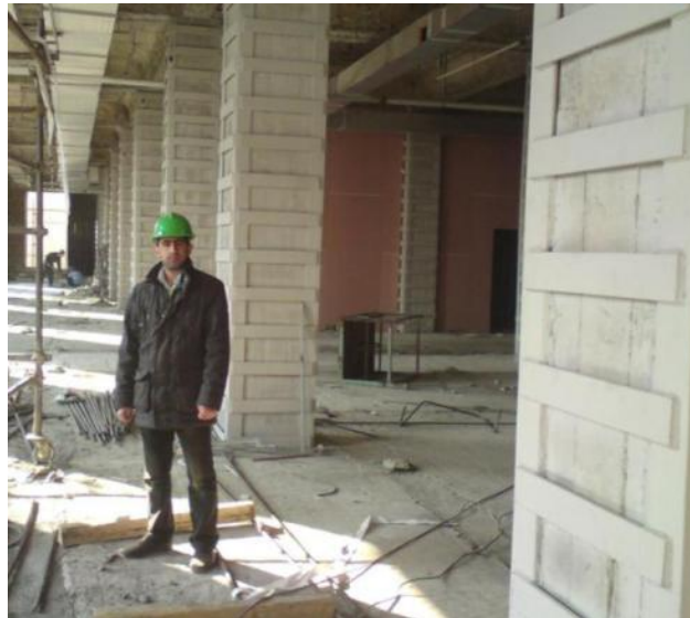
اجرای ژاکت فولادی
