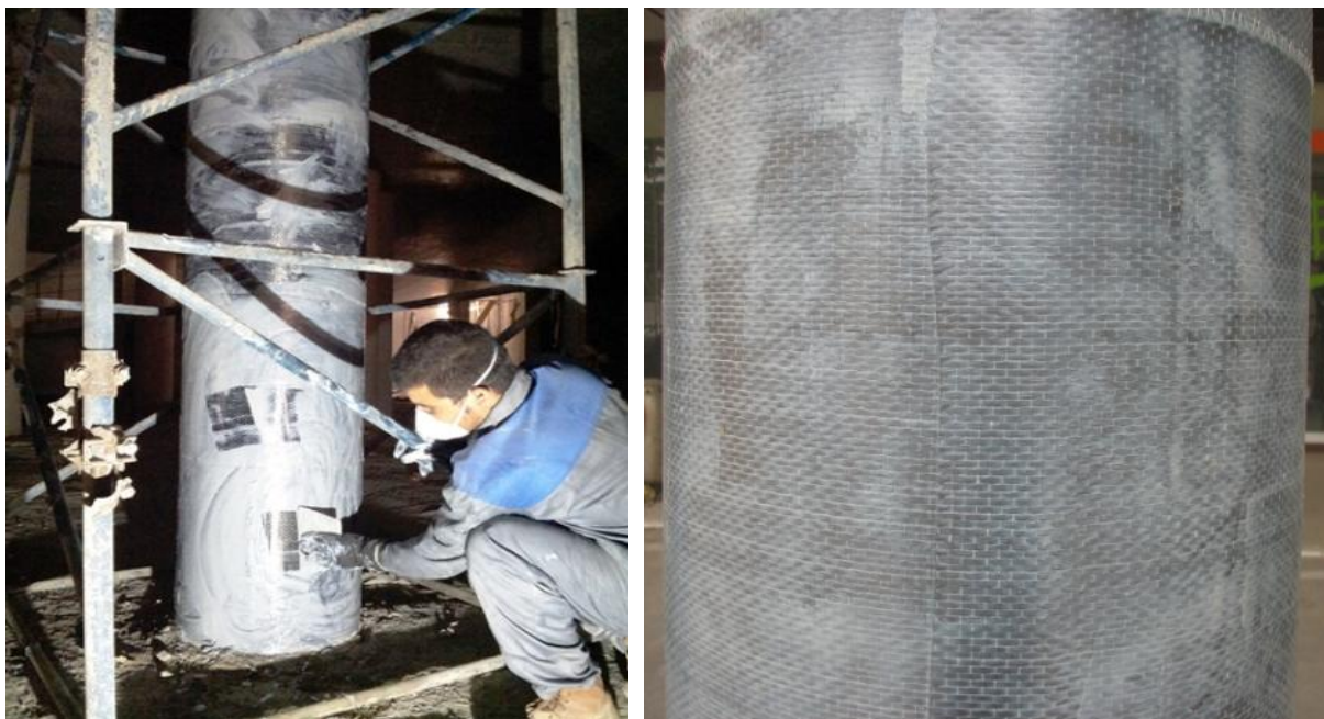
تقويت ستون ها با FRP در پروژه مجتمع اداری تجاری صدر
